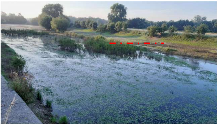
Vue de la limite amont
