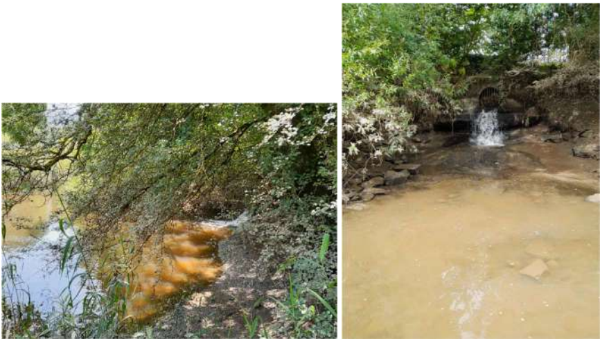
Vue de l'exutoire en rive droite d'un ruisseau (fosse de dissipation et chute d'eau susceptible de créer une concentration piscicole).
