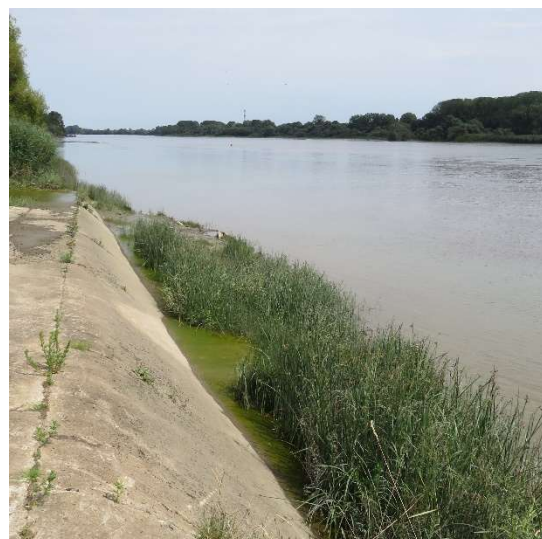
Station linéaire discontinue sur le secteur amont du bras de la Madeleine à Nantes
