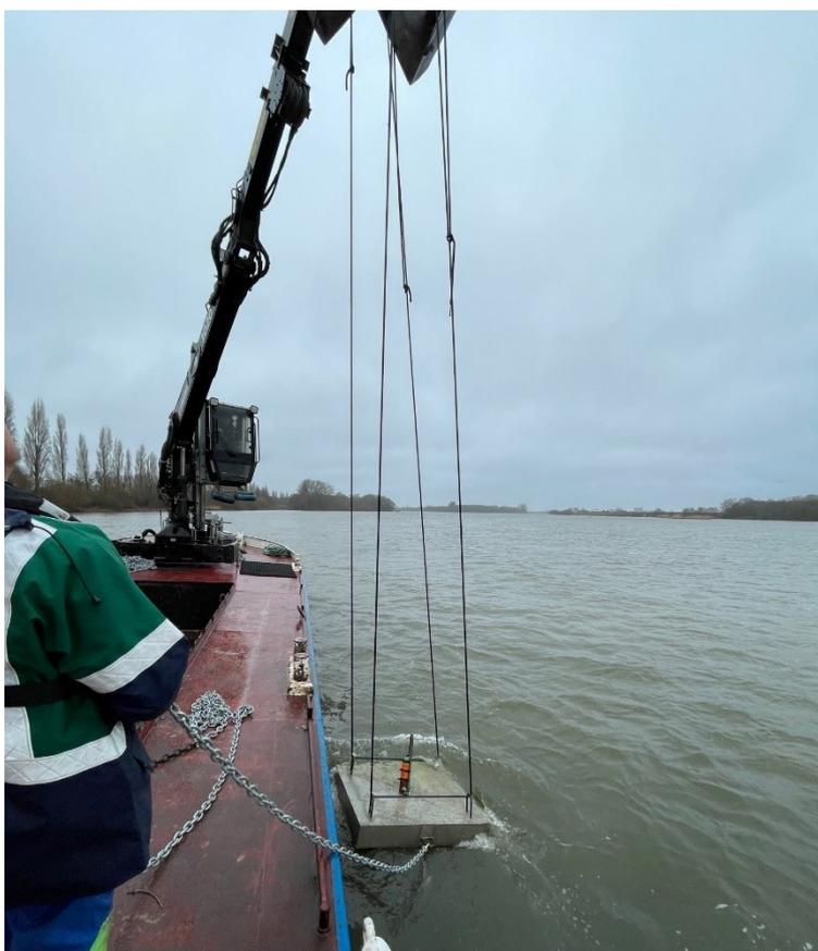
Figure 7 : Photo de l'immersion d'un récepteur acoustique signalisé en surface avec le bateau La Toue.
